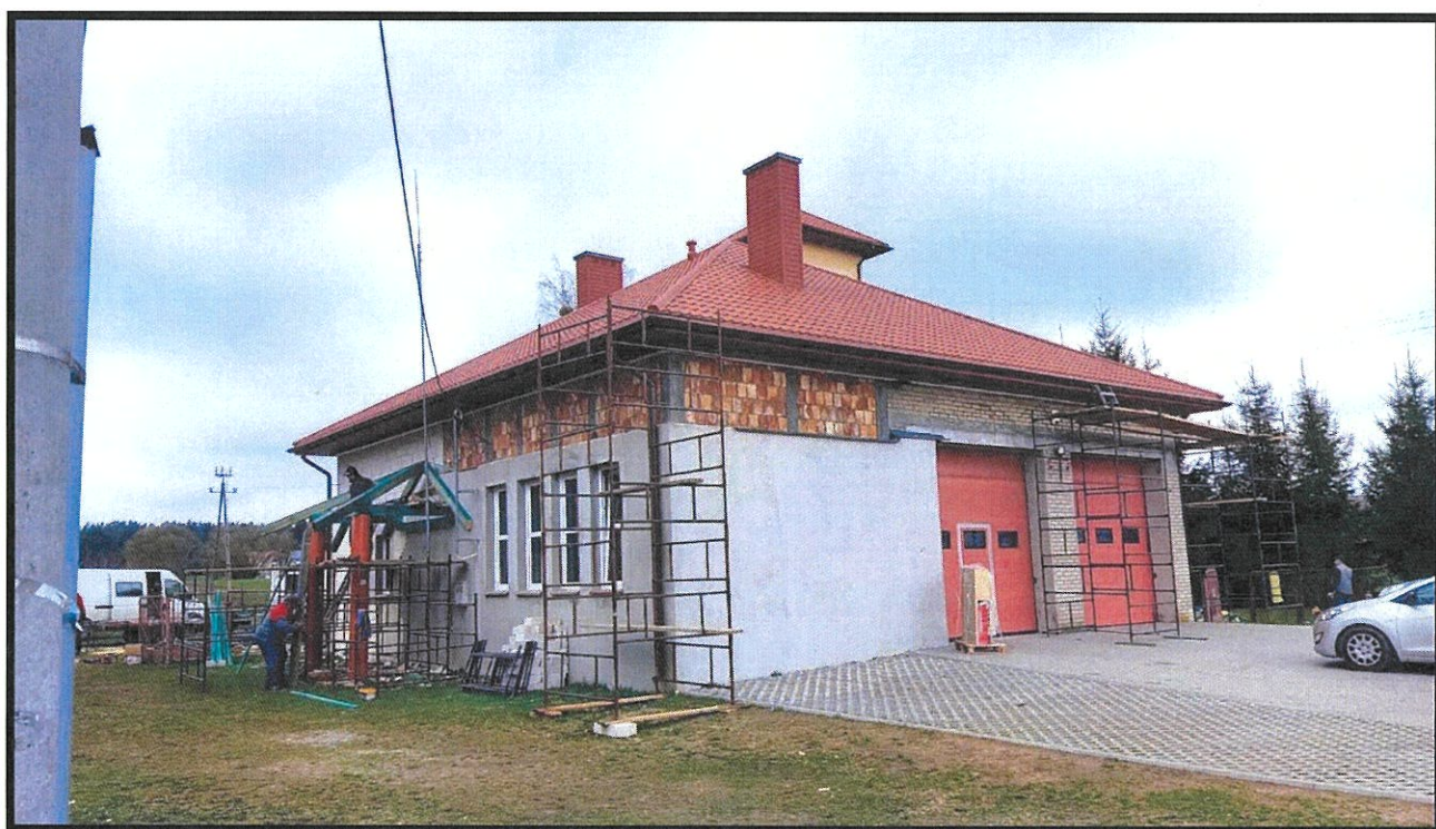
Ad. 5. Rozbudowa i termomodernizacja budynku Ochotniczej Straży Pożarnej w Czarnej Wsi Kościelnej – wieźba dachowa i pokrycie dachu
